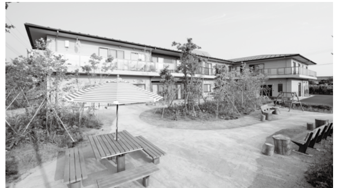
高齢者総合生活支援施設はな広場
