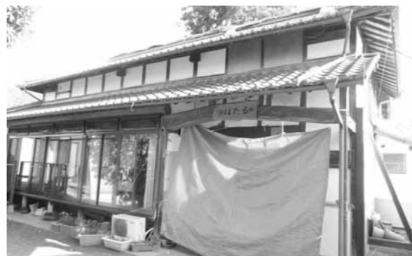
熊本県上益城郡の施設の外観
