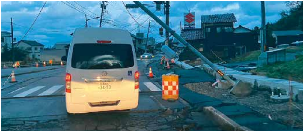
輪島市内県道1号（七尾輪島線）
