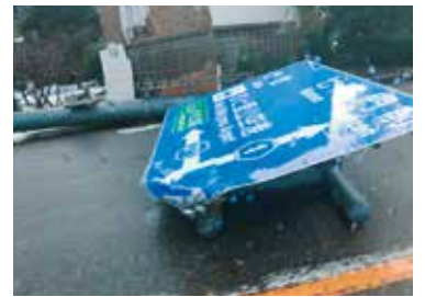
倒れた案内標識
