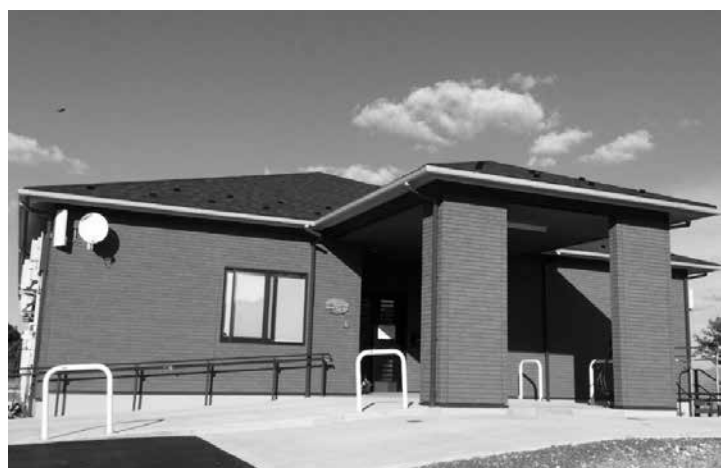
グループホームこいて (令和5年7月27日竣工)
